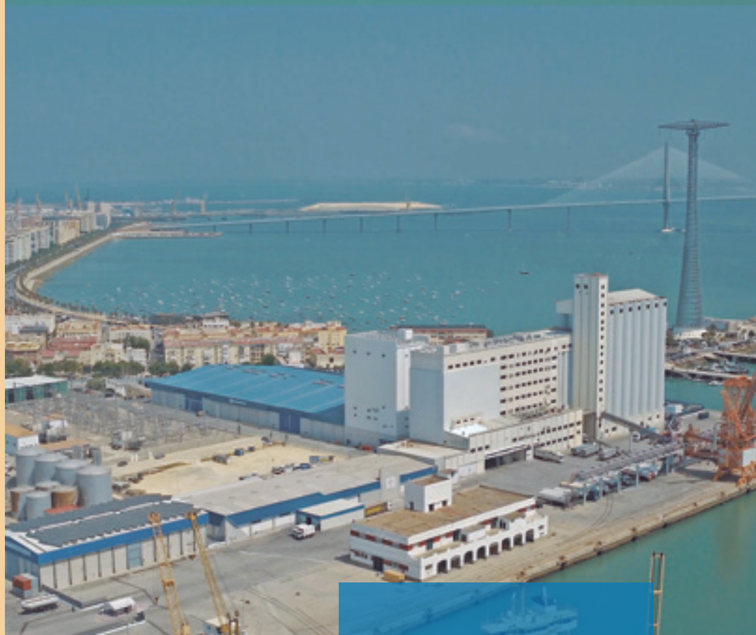
El recinto de la Zona Franca de Cádiz, con unas vistas espectaculares de la Bahía gaditana y el puente de La Pepa al fondo.
