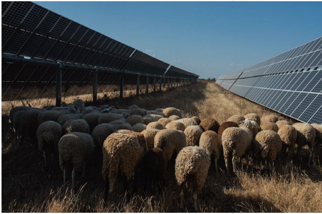
Ovejas pastan entre placas solares fotovoltaicas.
