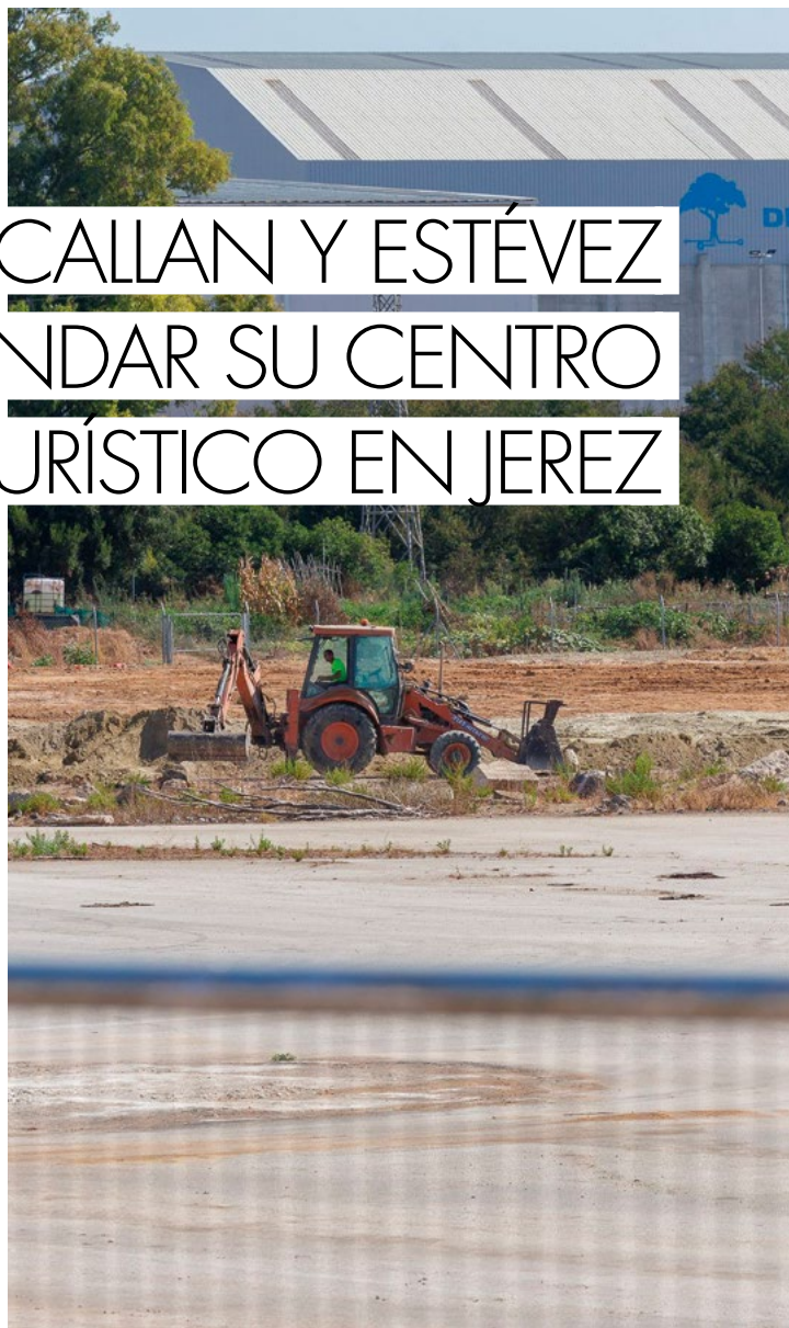
Una retroexcavadora, en los trabajos iniciados junto a Guadalcaacín.
