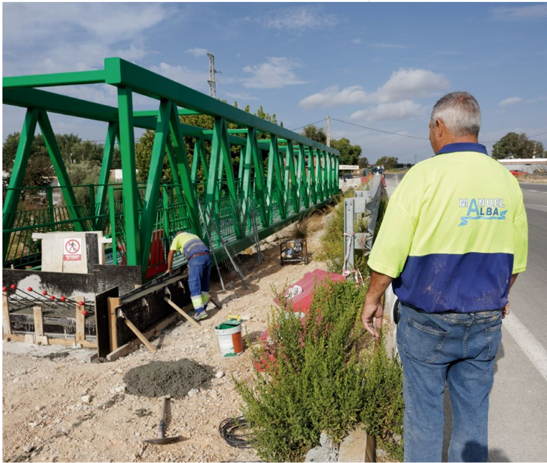
Trabajadores de Manuel Alba SA, durante las obras en el carril bici.
